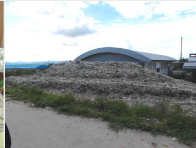
The Hua Hin landfill
